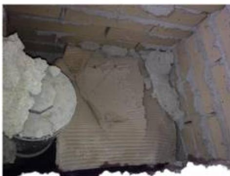
**Figura 1. Obstrucción del tubo de evacuación general de las cocinas del Edificio B Bloque 1**
