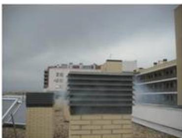
**Figura 8. Detalle de la evacuación de humo en la cubierta de las cocinas**
